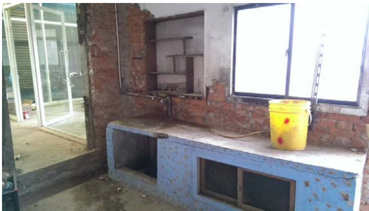
苗栗安養中心工程
